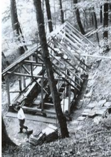
Die Hütte im Rohbau
